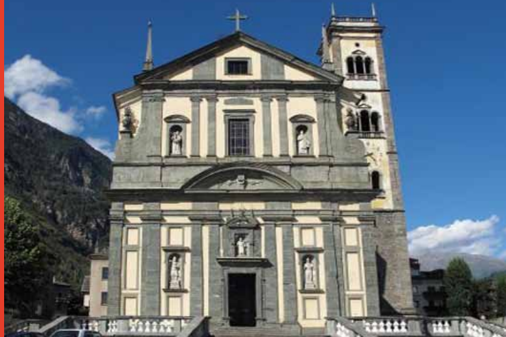
La facciata principale
