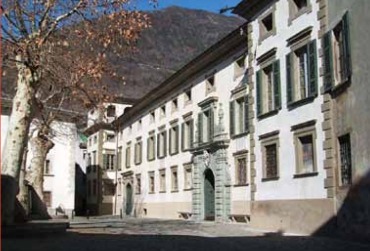
Prospetto del palazzo nel centro storico
