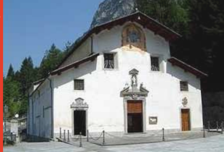
La facciata principale del santuario
