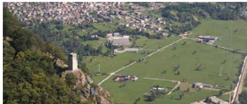
La Torre di Segname che domina la Valle
